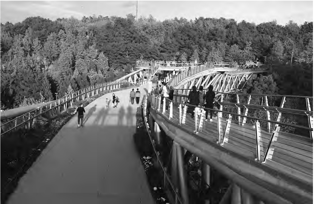
4. Tehran Nature Bridge, 2010-2014, progettato da Leila Araghian per collegare due parchi separati da un'autostrada. Foto G. Canto Moniz, I. Ferreira.
